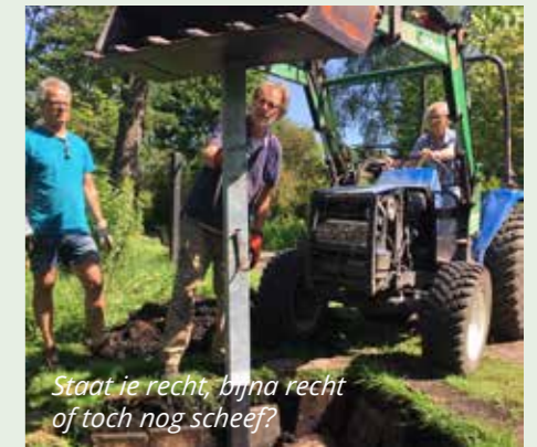
De metalen schacht krijgt grond-ankers aangelast in de werkplaats.
